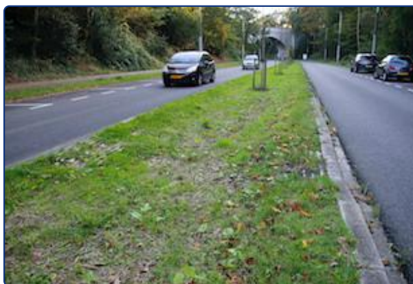
Infiltratie in berm Cattepoelseweg.
