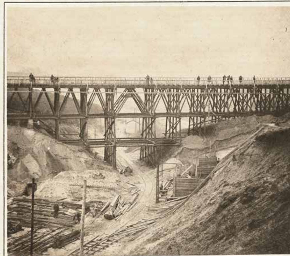
Het viaduct in den Apeldoornschen weg te Arnhem in aanbouw. (Links beneden) het gieten der één meter dikke funderingsplaten aan den stadzijde der doorgraving. Op den achtergrond de houten noodbrug. Dat deze noodbrug ook van groote afmeting is laat een vergelijking met de personen die er op staan duidelijk zien.
