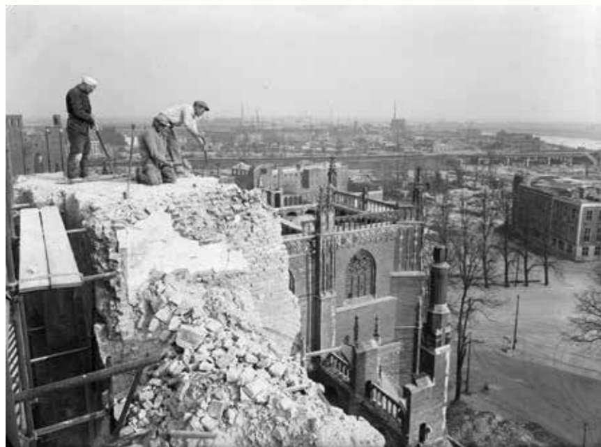
Een prachtige foto uit 1946 van slopers, genomen vanaf een steiger hoog op de zwaar beschadigde St. Eusebiuskerk. Foto Dick Renes, Nationaal Archief 901-6885.
